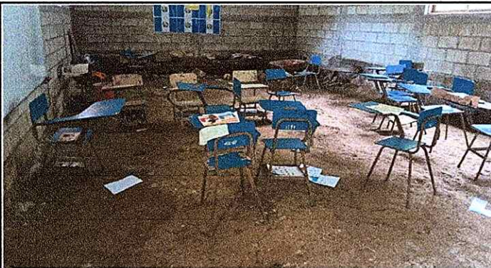
Foto 3: Reparacion de piso dentro del aula
