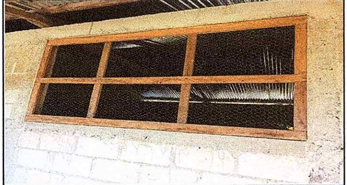
Foto 2: sustitucion de ventana
