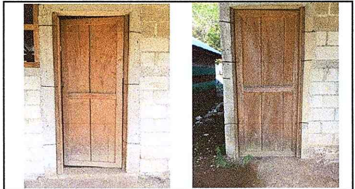
Foto 4: Sustitucion de Puertas
